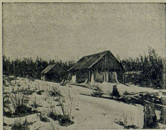
Рис. 9. Зимний ключ, прорвавшийся в барак, где жили железнодорожные рабочие. Вода в момент прорыва была переохлаждена. По выходе наружу она тотчас застыла и заполнила барак льдом.
